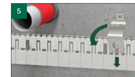
Umieścić kątowniki w slotach taśmy ze stali nierdzewnej.
