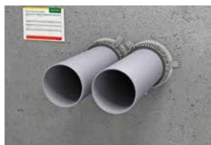
Zerowa odległość pomiędzy opaskami (rury bez izolacji).
