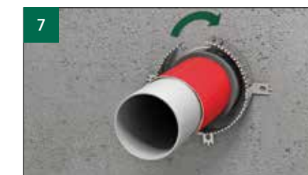
Założyć końce taśmy stalowej na siebie, odgiąć zakładki i umieścić je w slotach i ponownie zagiąć w celu zamknięcia opaski.
