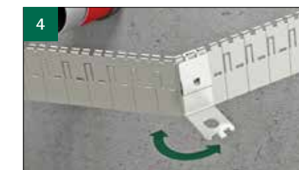
Odciąć potrzebną ilość taśmy ze stali nierdzewnej używając kątownika montażowego*.
