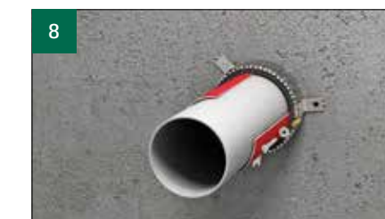
Przymocować opaskę do ściany przez otwory w kątownikach używając załączonych dybli lub pręta gwintowanego M6-M8 oraz nakrętek, na wylot przez ścianę.
