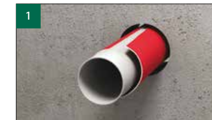
Zamontować rurę i w razie potrzeby zaizolować.
