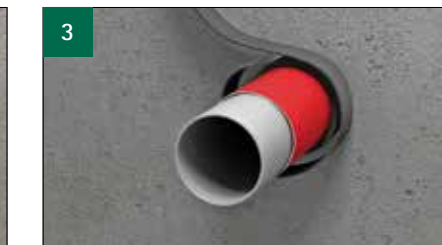
Owinąć taśmę ogniochronną (ilość zwojów podana w poniższej tabeli) wokół rury (lub izolacji) na zakładkę do 20 mm.
