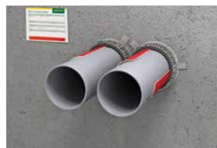
Zerowa odległość pomiędzy opaskami (rury izolowane).
