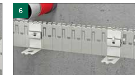
Zamontować kątowniki na taśmie ze stali nierdzewnej poprzez zagłębienie.
